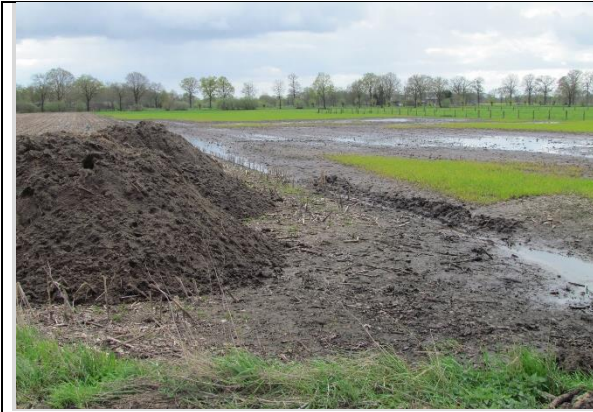
Abbildung 3: Entwässerungsmaßnahme am NSG Emsdettener Venn
