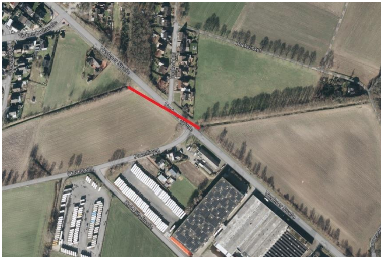
Abbildung 356: BOR-STAD-008, rot vorhandene Gewässerverrohrung, Luftbild; TIM online 11.09.2023
